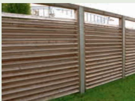
Sichtschutzwand aus Lärchenbohlen mit Aluwinkeln befestigt, für ein Schwimmbad
