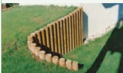
Kessel-druckimprägnierte Hölzer bekommen im Laufe der Jahre einen angenehmen gräulichen Farbton
