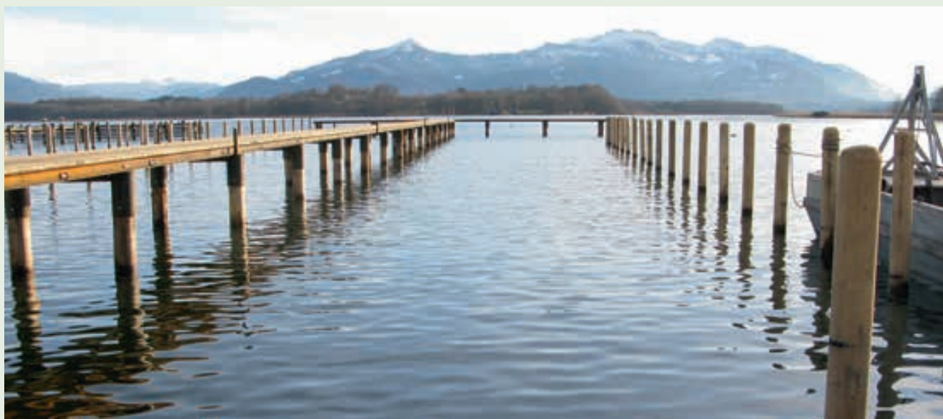
Eichenrammpfähle zylindrisch gefräst, 280 mm Ø, im Chiemsee
