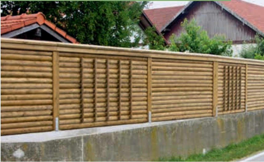
Rundholzwand Nr. 58.1 mit Eisenschuhen Nr. 55.51 auf alte Betonmauer montiert
