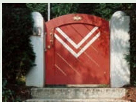
Gartentür. Schwerer verzapfter Rahmen, kesseldruckimprägniert, nachgetrocknet, 2 x farbig lasiert.
