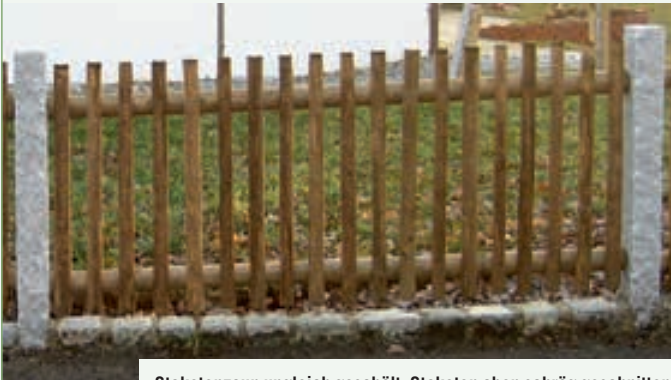
Staketenzaun ungleich geschält, Staketeten oben schräg geschritten
