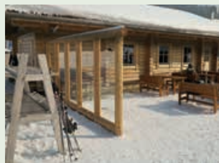
Stabile Windschutzglaswand, in 16 cm starke Lärchenrundhölzer eingebaut
