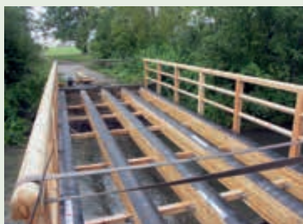
Brückenträger aus Lärchenholz BSH, vorbereitet zum Brückenbelag anbringen
