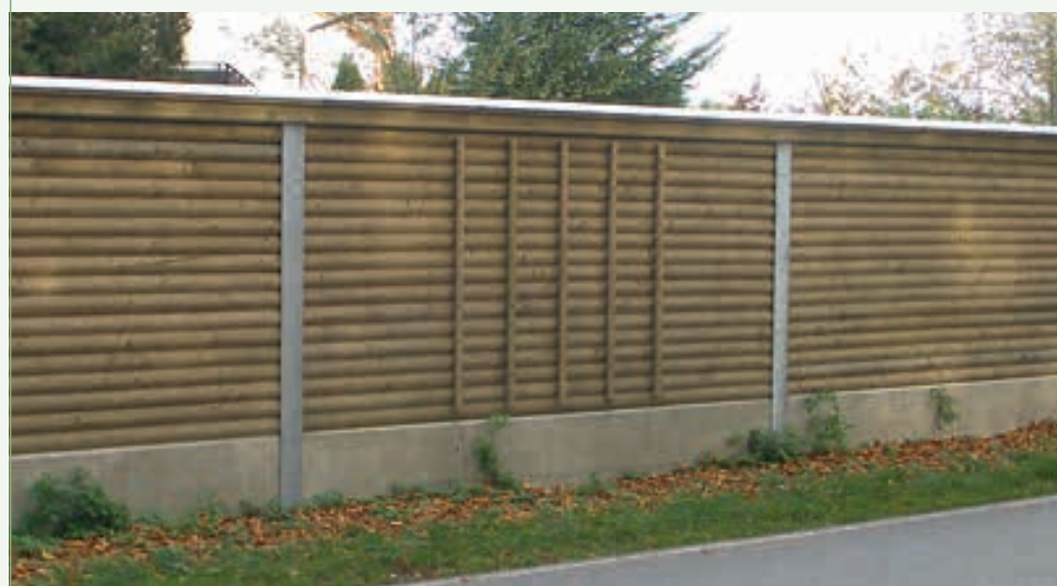
Reflektierende Rundholz-Lärmschutzwand Nr. 58.1 ohne Betonteile
