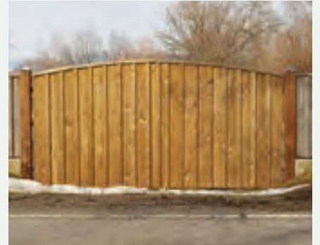
Gartentor aus verzapften Rahmen, oben rund, mit Deckleisten, Fichte braun kesseldruckimprägniert.
