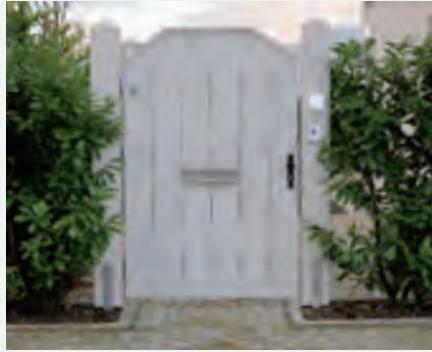
Speziell angefertigtes Eingangstürl, verzapfter Rahmen, Bretter und Abdeckprofilholz, weiß lasiert.
