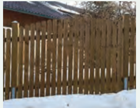
Hobellattenzaunfelder oben rund, dem schrägen Gelände angepasst.
