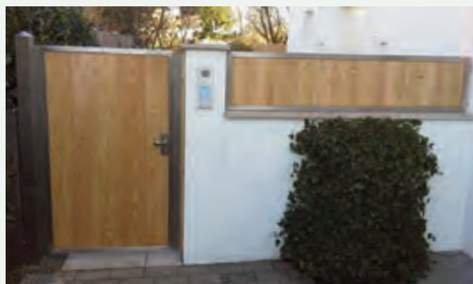
Sichtschutztür mit Wandelement in Edelstahlrahmen montiert.
