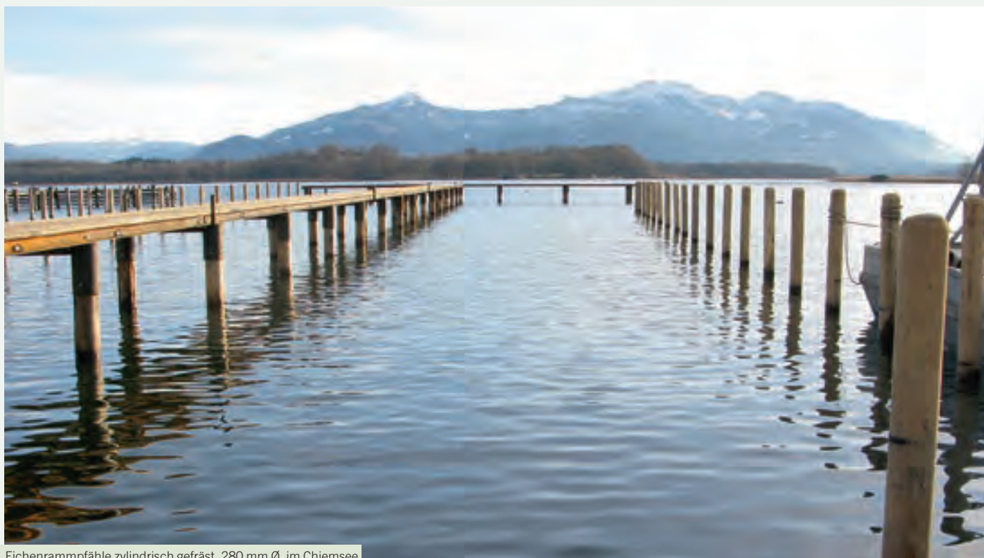
Eichenrammpfähle zylindrisch gefräst, 280 mm Ø, im Chiemsee
