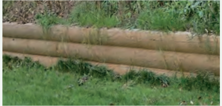
Böschungssicherung mit profilierten Fichtenrundhölzern Ø 16 cm, Fichte grün kesseldruckimprägniert.
