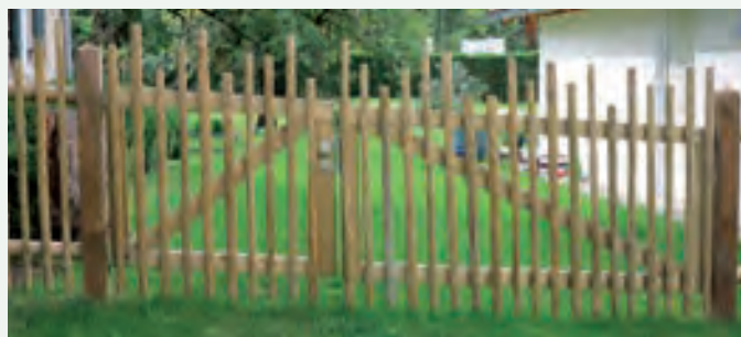
Tor aus dem Winkel mit Hanichlfüllung
