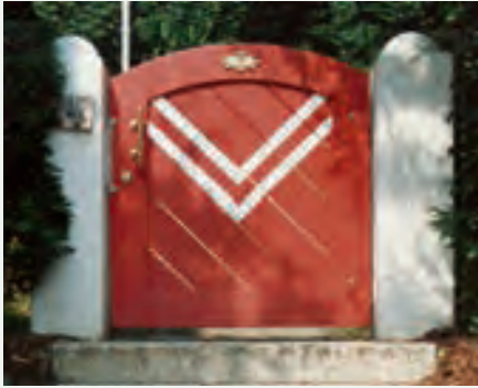
Gartentürl schwerer, verzapfter Rahmen, kesseldruckimprägniert, nachgetrocknet, 2x farbig lasiert.
