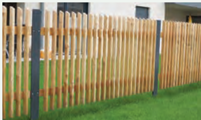
Hobellattenzaun zwischen beschichtete T-Profile montiert.
