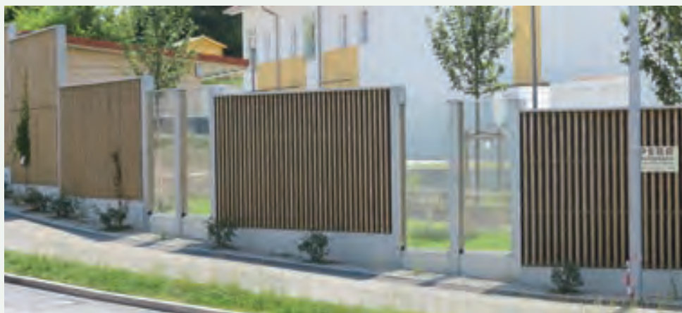
Hochabsorbierende Lärmschutzwand im Wechsel mit Glaselementen.
