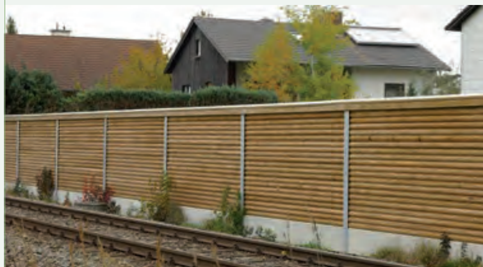
Reflektierende Rundholz-Lärmschutzwand Nr. 58.1 mit Abdeckdach und Betonteil
