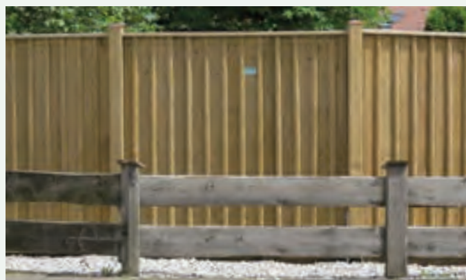
Sicht- und Schallschutzwand mit Bohlen und halbrunden (oder vierkant) Stoßlatten, braun.
