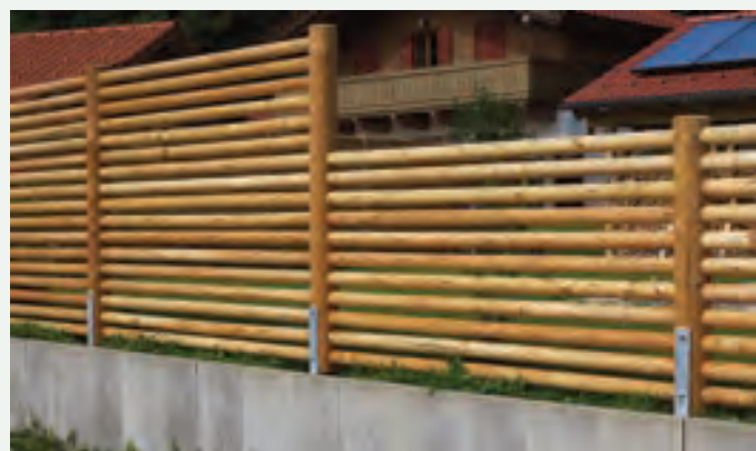
Sichtschutzwand aus Lärchenrundhölzern in ausgefräste Säulen montiert.
