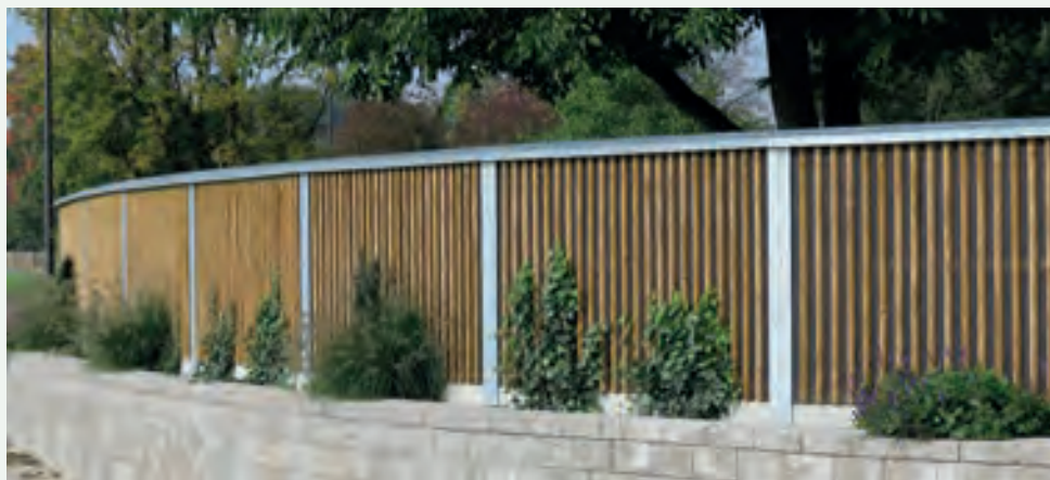
Hochabsorbierende Lärmschutzwand hinter bauseitige Steinmauer gebaut.
