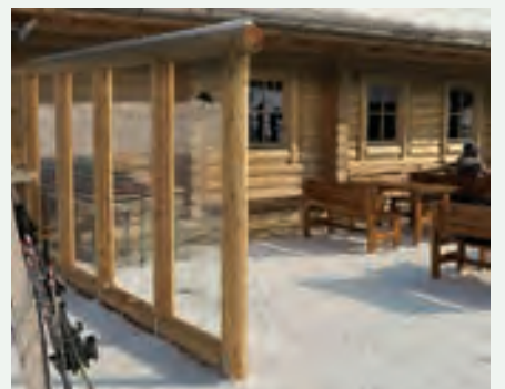
Stabile Windschutzglaswand in 16 cm starke Lärchenrundhölzer eingebaut.
