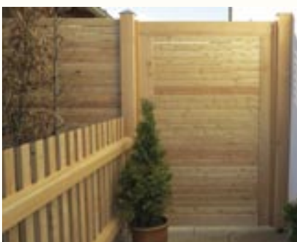
Sichtschutzwand Lärche, Rhombuslatten in gefalzte Pfosten montiert. Türl verzapfter Rahmen, Latten in Rahmen gezapft.
