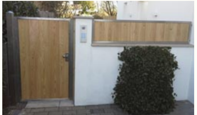
Sichtschutztor mit Wandelement in Edelstahlrahmen montiert.
