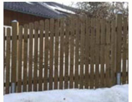
Hobellattenzaunfelder oben rund, dem schrägen Gelände angepasst.
