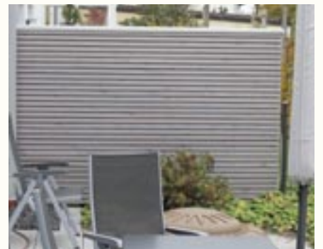
Lasierter Terrassentrennwand, Rhombuslatten beidseitig auf schwarze Kertopplatten montiert.
