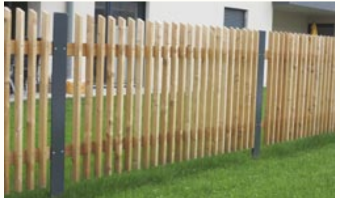
Hobellattenzaun zwischen beschichtete T-Profile montiert.
