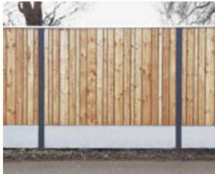
Reflektierende Schallschutzwand mit senkrechten Lärchenbrettern in verschiedenen Breiten, auf Furnierschichtplatte montiert.
