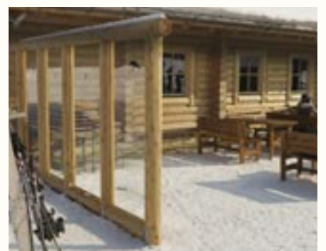
Stabile Windschutzglaswand in 16 cm starke Lärchenrundhölzer eingebaut.
