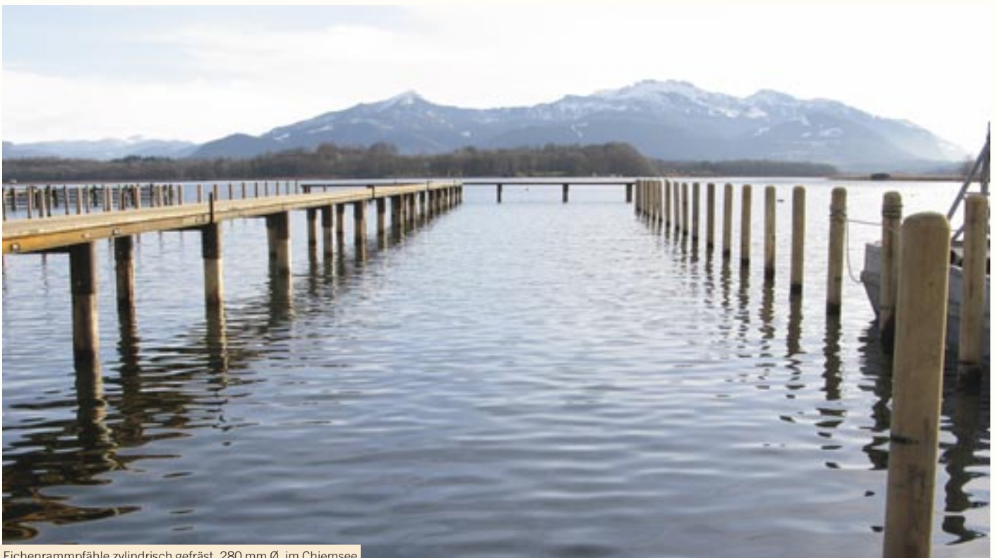
Eichenrammpfähle zylindrisch gefräst, 280 mm Ø, im Chiemsee
