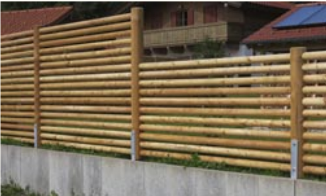
Sichtschutzwand aus Lärchenrundhölzern in ausgefräste Säulen montiert.
