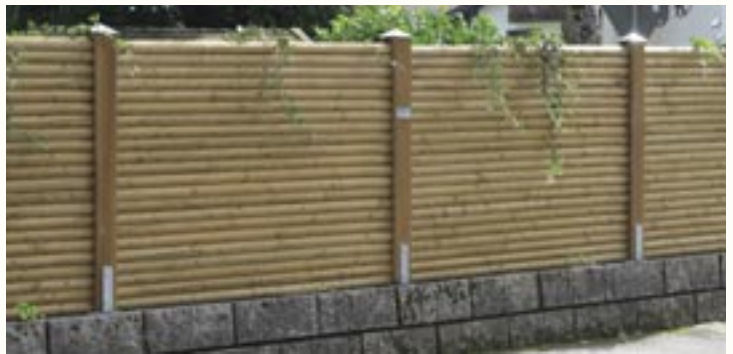
Sichtschutzzaun auf alte Mauer befestigt. An der Innenseite Wand mit 1 m tief einbetonierten HEA-Trägern stabilisiert.
