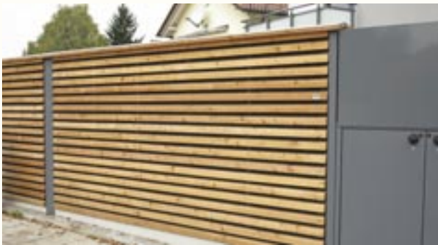
Lärmschutzwand mit waagerechten Rhombusleisten in farbig beschichteten HEA-Trägern montiert.
