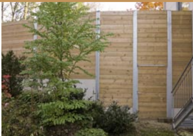
Lärmschutzwand Nr. 58.5, ca. 4 m hoch mit Bohlen 77 x 160 mm und Betonteil. Wandanschluss mit U-Träger und Lärmschutztüre auf Stahlrahmen
