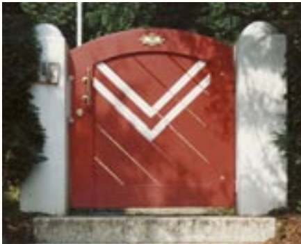
Gartentür kleiner, verzapfter Rahmen, kesseldruckimprägniert, nachgetrocknet, 2x farbig lasiert.
