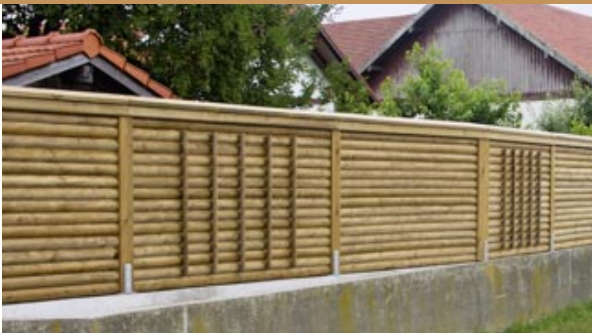
Rundholzwand Nr. 58.1 mit Eisenschuhen Nr. 55.51 auf alte Betonmauer montiert
