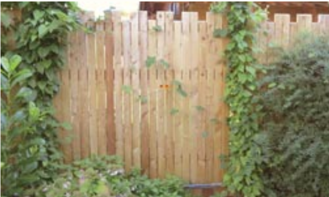
Sichtschutzzaun mit höhenversetzten Hobellatten 25 x 65 mm.
