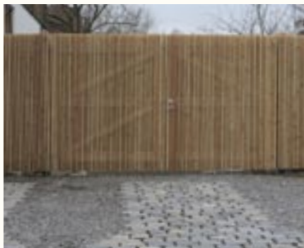
Sichtschutzzaun und Tor, Lärche mit beidseitig versetzt angebrachten Hobellatten. Schmale Seite sichtbar.
