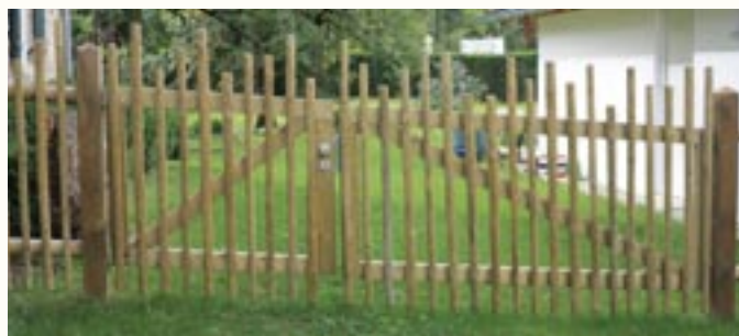
Tor aus dem Winkel mit Hanichlfüllung
