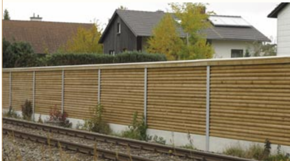
Reflektierende Rundholz-Lärmschutzwand Nr. 58.1 mit Abdeckdach und Betonteil
