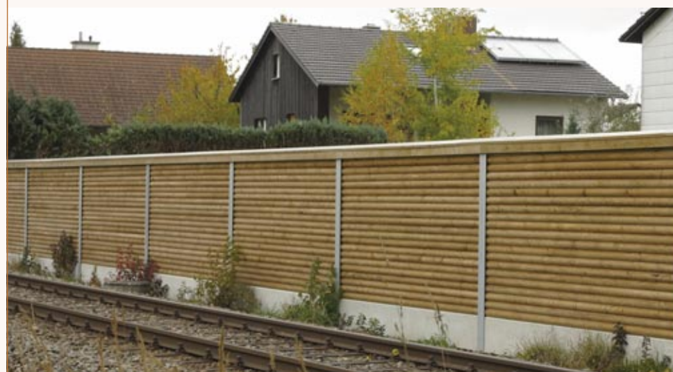
Reflektierende Rundholz-Lärmschutzwand Nr. 58.1 mit Betonteilen
