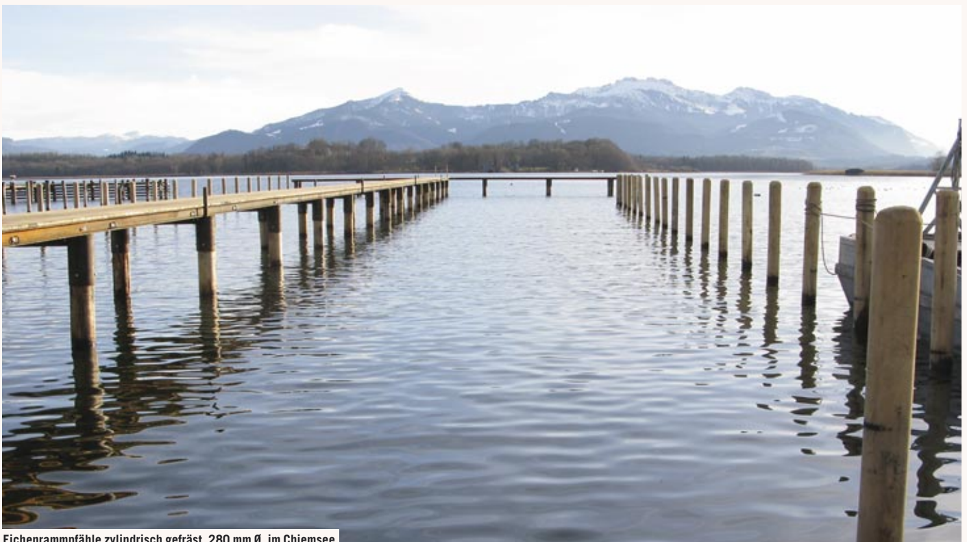
Eichenrammpfähle zylindrisch gefräst, 280 mm Ø, im Chiemsee
