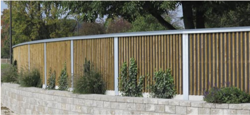
Hochabsorbierende Lärmschutzwand hinter bauseitige Steinmauer gebaut.
