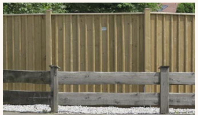
Sicht- und Schallschutzwand mit Bohlen und halbrunden Stoßlatten, braun kesseldruckimprägniert.
