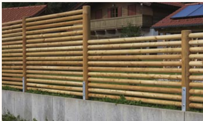
Sichtschutzwand aus Lärchenrundhölzern in ausgefräste Säulen montiert.
