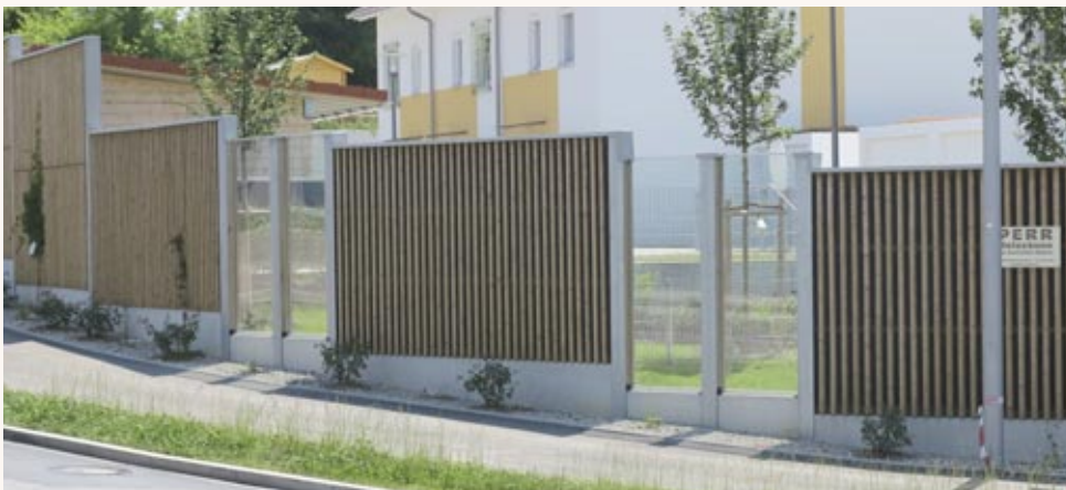
Hochabsorbierende Lärmschutzwand im Wechsel mit Glaselementen.
