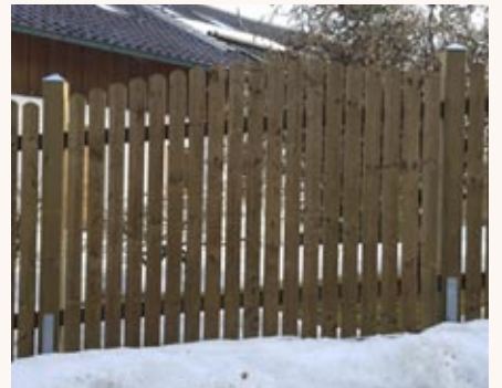
Hobellattenzaunfelder oben rund, dem schrägen Gelände angepasst.
