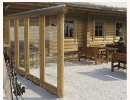
Stabile Windschutzglaswand in 16 cm starke Lärchenrundhölzer eingebaut.
