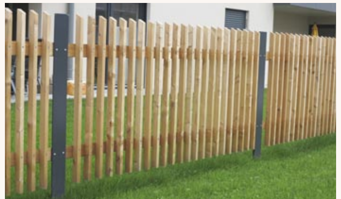
Hobellattenzaun zwischen beschichtete T-Profile montiert.
