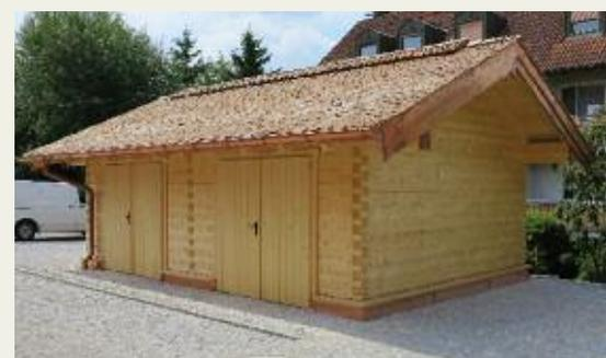
Wir bauen Rundholzblockhäuser in solider handwerklicher Ausführung. Die getrockneten Fichtenstämme werden mit einer Nut und Feder verbunden und durchgehend mehrmals vom Boden bis zum Dach verschraubt. Rundstammhäuser fertigen wir in 110 mm, 160 mm, 210 mm und 250 mm Stammdurchmesser.
