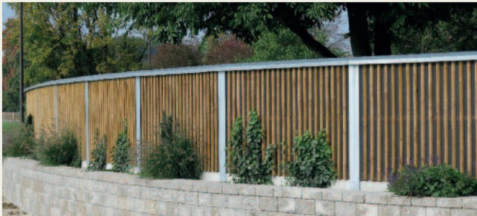
Hochabsorbierende Lärmschutzwand hinter bauseitige Steinmauer gebaut.
