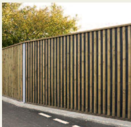
**Abbildung links:** Innenansicht hochabsorbierende Lärmschutzwand.
