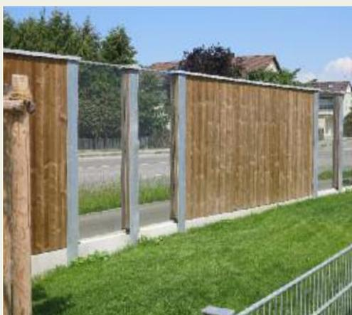
**Abbildung rechts:** Hochabsorbierende Lärmschutzwand auf Betonmauer mit schweren Spezialdübeln befestigt.
