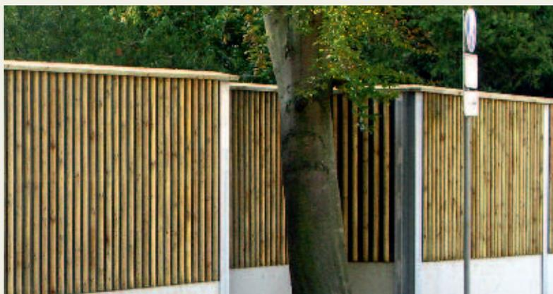
Bäume können durch ein zurückversetztes Feld ausgespart werden. Zugleich wird die Wand aufgelockert.
