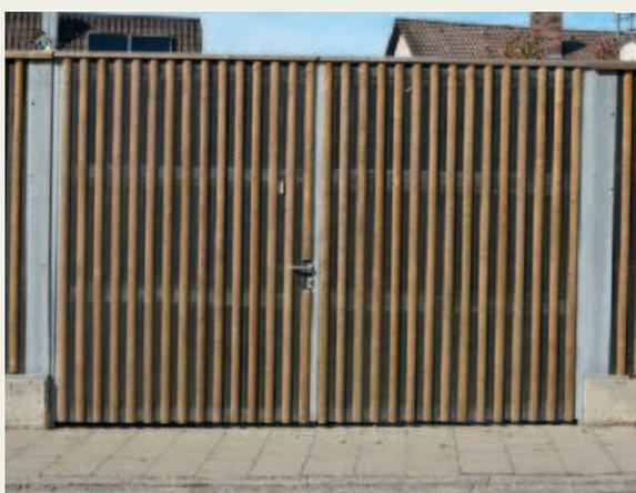
Lärmschutztore und -türen werden aus stabilen Stahlrahmen angefertigt und feuerverzinkt.
