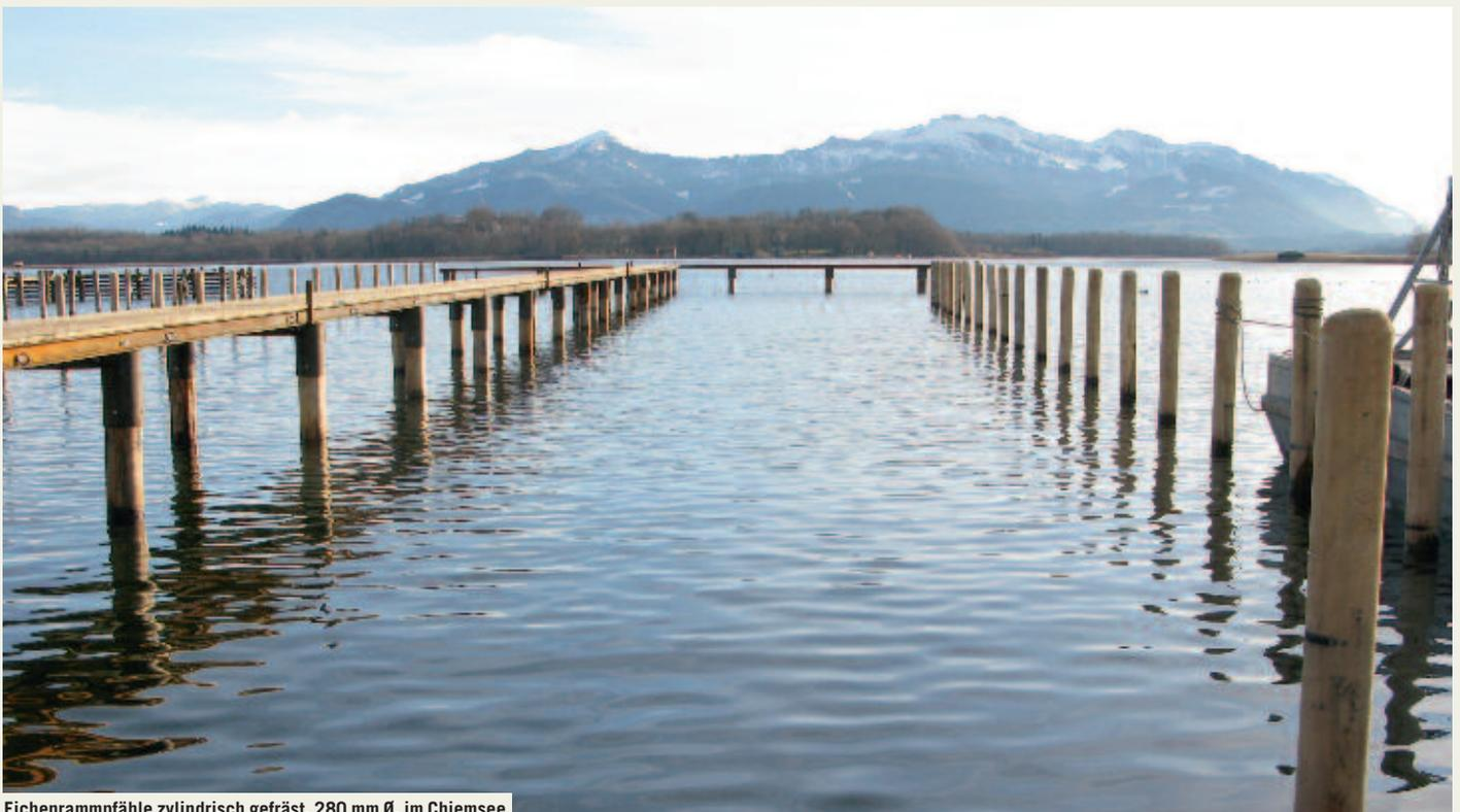
Eichenrammpfähle zylindrisch gefräst, 280 mm Ø, im Chiemsee
