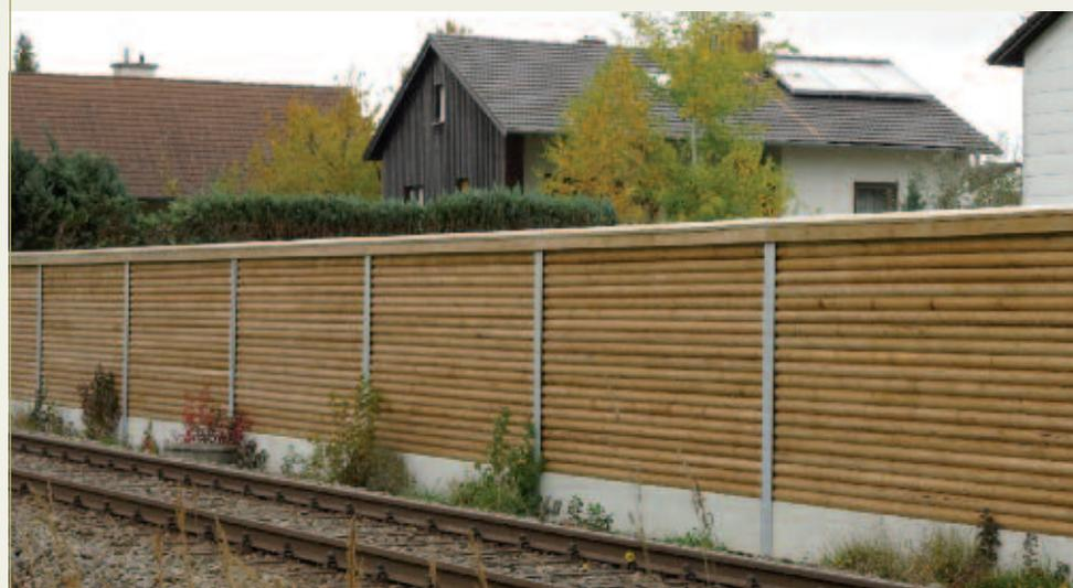
Reflektierende Rundholz-Lärmschutzwand Nr. 58.1 mit Abdeckdachl und Betonteil
