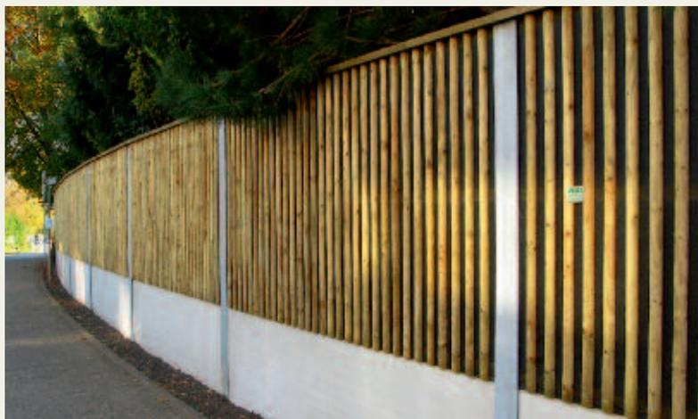
Hochabsorbierende Lärmschutzwand mit Halbrundlatten am Schalleintritt. Betonteile und Wände zwischen HEA-Träger 160 mm montiert. Träger in Einzelfundamente mit Bewehrung betoniert.
