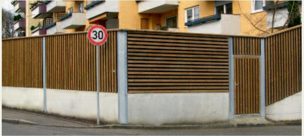
Hochabsorbierende Lärmschutzwand mit Halbrundlatten am Schalleintritt und oberen Schallschutzglas.
