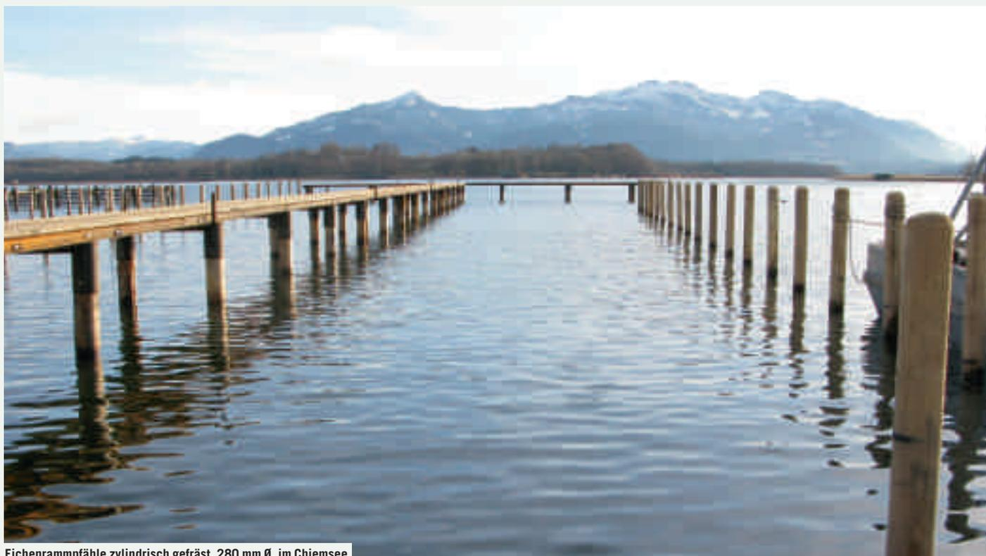
Eichenrammpfähle zylindrisch gefräst, 280 mm Ø, im Chiemsee
