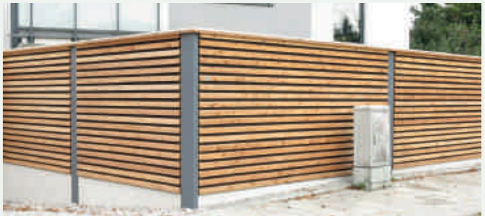
Hochabsorbierende Lärmschutzwand mit Halbrundlatten am Schalleintritt und Schallschutzglaselementen. Lärche kesseldruckimprägniert.
