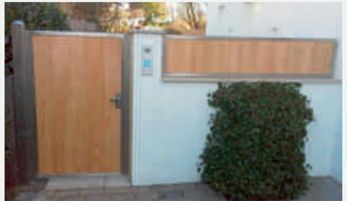
Sichtschutztor mit Wandelement in Edelstahlrahmen montiert.
