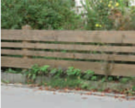
Bretterzaun braun kesseldruckimprägniert, mit unterschiedlich breiten Brettern montiert.
