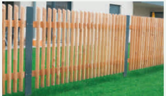
Hobellattenzaun zwischen beschichtete T-Profile montiert.
