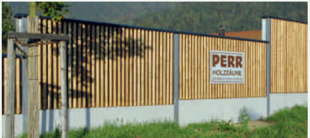
Hochabsorbierende Schallschutzwand mit Rhombuslatten Lärche natur am Schalleintritt. Betonteile können in verschiedenen Höhen gefertigt werden.
