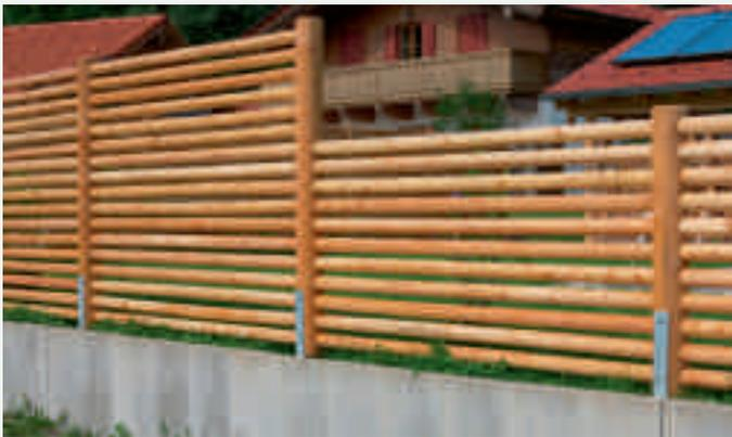
Sichtschutzwand aus Lärchenrundhölzern in ausgefräste Säulen montiert.
