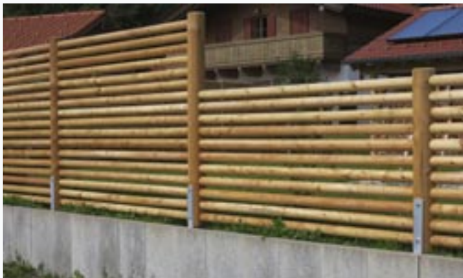
Sichtschutzwand aus Lärchenrundhölzern in ausgefräste Säulen montiert.
