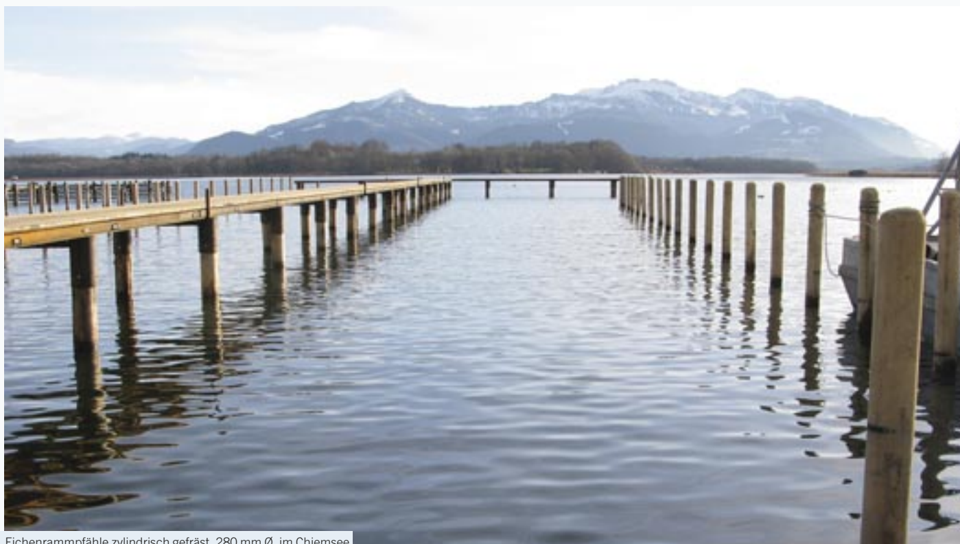
Eichenrammpfähle zylindrisch gefräst, 280 mm Ø, im Chiemsee
