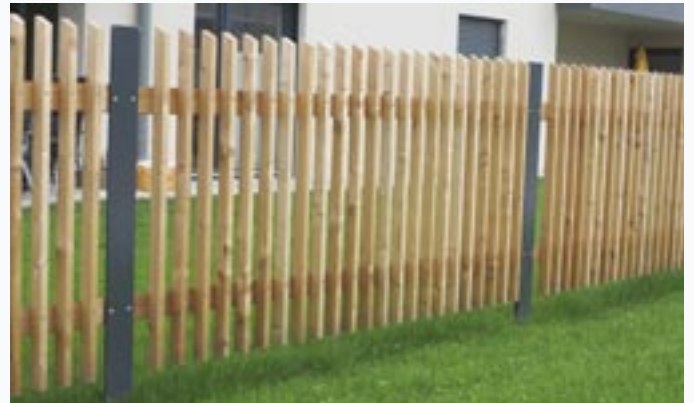
Hobellattenzaun zwischen beschichtete T-Profile montiert.
