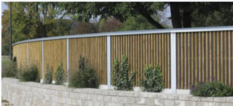
Hochabsorbierende Lärmschutzwand hinter bauseitige Steinmauer gebaut.
