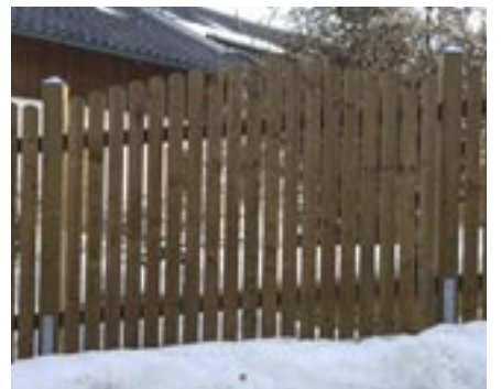
Hobellattenzaunfelder oben rund, dem schrägen Gelände angepasst.
