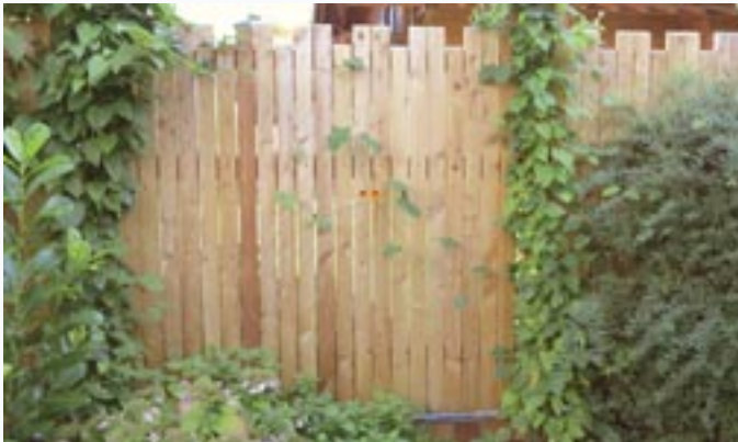
Sichtschutzzaun mit höhenversetzten Hobellatten 25 x 65 mm.
