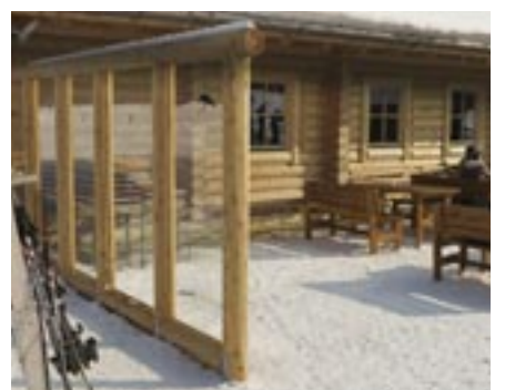
Stabile Windschutzglaswand in 16 cm starke Lärchenrundhölzer eingebaut.
