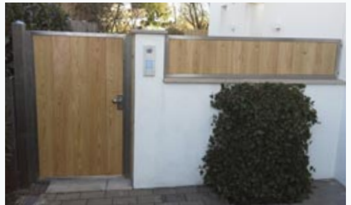
Sichtschutztor mit Wandelement in Edelstahlrahmen montiert.
