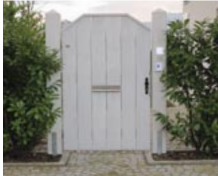
Speziell angefertigtes Eingangstürfl, verzapfter Rahmen, Bretter und Abdeckprofilholz, weiß lasiert.
