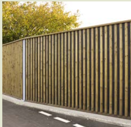
Abbildung rechts: Hochabsorbierende Lärmschutzwand auf Betonmauer mit schweren Spezialdübeln befestigt.
