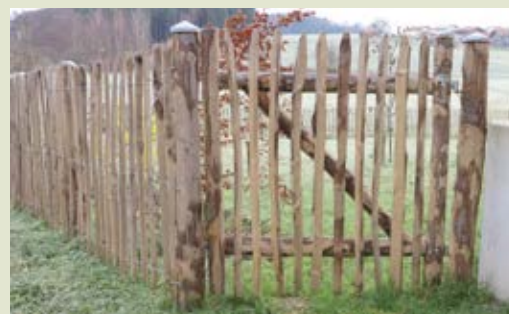
Türrahmen aus Kastanienhalbrundhölzern geschraubt, mit Staketenfüllung
