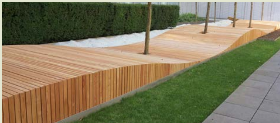
Holzwehle aus österreichischem Gebirglärchenholz, am Europäischen Patentamt in München, von uns gefertigt und montiert.
