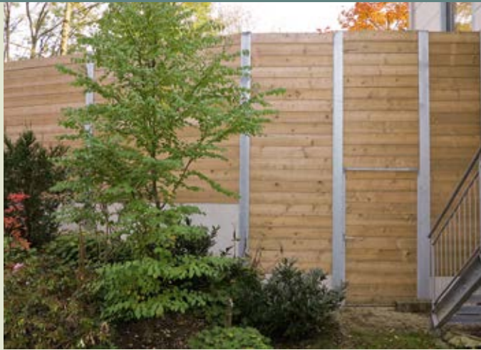
Lärmschutzwand Nr. 58.5, ca. 4 m hoch mit Bohlen 77 x 160 mm und Betonteil. Wandanschluss mit U-Träger und Lärmschutztüre auf Stahlrahmen
