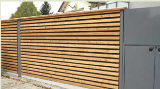
Lärmschutzwand mit horizontalen Rhombusleisten in farbig beschichteten HEA-Trägern montiert.
