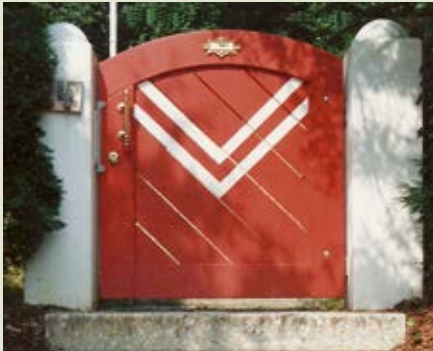
Gartentür schwerer, verzapfter Rahmen, kesseldruckimprägniert, nachgetrocknet, 2x farbig lasiert.
