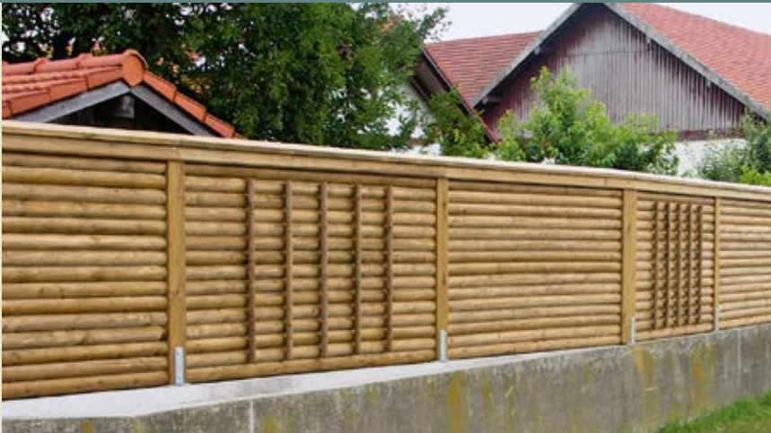
Rundholzwand Nr. 58.1 mit Eisenschuhen Nr. 55.51 auf alte Betonmauer montiert
