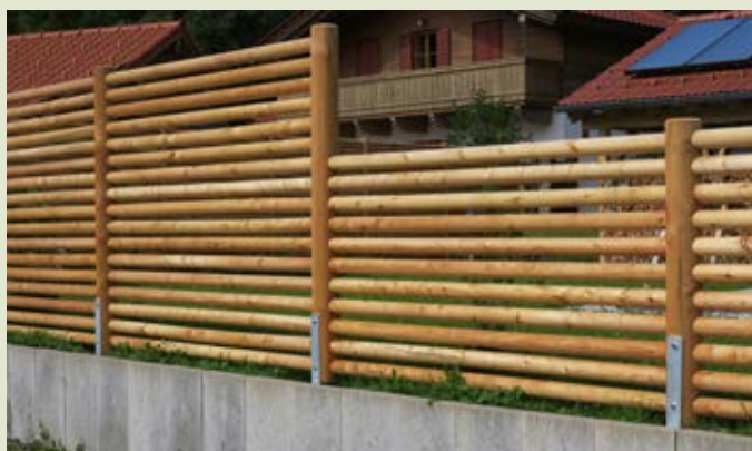
Sichtschutzwand aus Lärchenrundhölzern in ausgefräste Säulen montiert.
