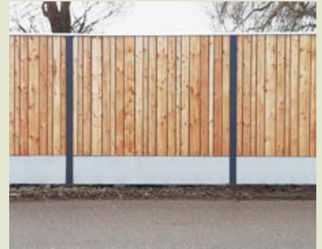
Reflektierende Schallschutzwand mit senkrechten Lärchenbrettern in verschiedenen Breiten, auf Furnierschichtplatte montiert.
