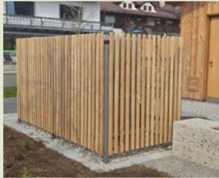
Müllcontainerverkleidung, auf Edelstahlkonstruktion montiert.
