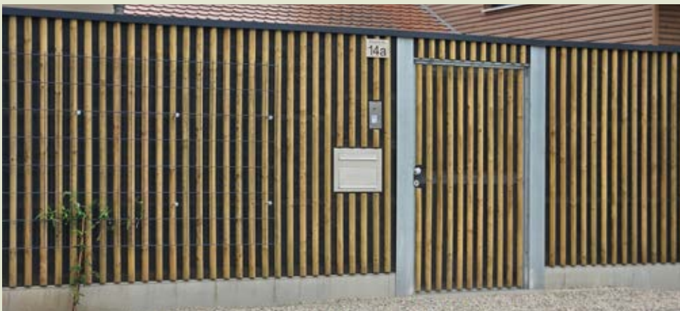
Schallschutzwand mit Stahlmattenspalier und Eingangstüre.
