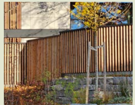
Hochabsorbierende Sicht- und Lärmschutzwand, mit vertikalen Vierkantlatten. Dem Geländeverlauf angepasst.
