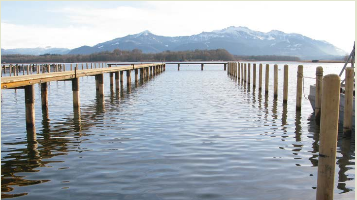
Eichenramppfähle zylindrisch gefräst, 280 mm Ø, im Chiemsee verbaut.
