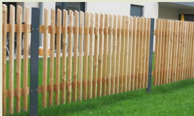
Hobellattenzaun zwischen beschichtete T-Profile montiert.
