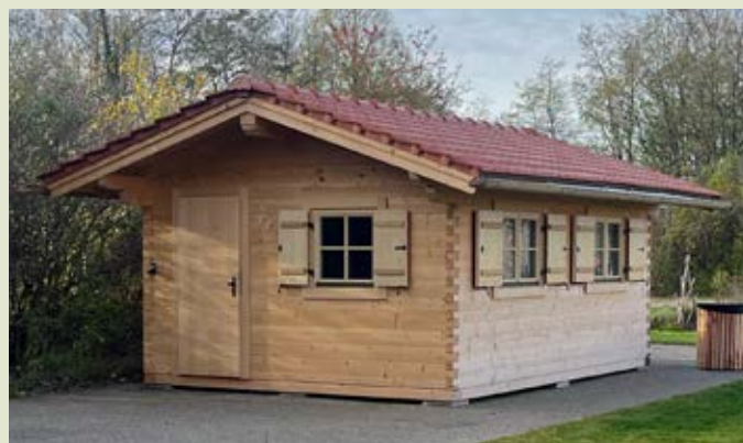
Ob Vierkant- oder Rundholzblockhaus – in unserem Blockhausbetrieb fertigen wir Blockhäuser individuell nach Maß sowie Ihren Wünschen an. Darüber hinaus bieten wir eine fachgerechte Ausführung sämtlicher Zimmerarbeiten und Holzkonstruktionen an. Mehr hierzu erfahren Sie auf Seite 91.
