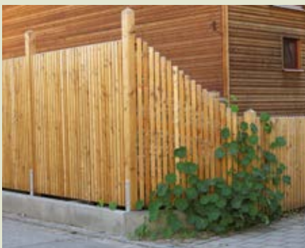
Sichtschutz in Lärche natur mit schrägem Übergang zum Hobellattenzaun.
