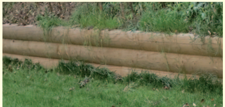
Böschungabsicherung mit profilierten Fichtenrundhölzern Ø 16 cm, Fichte grün kesseldruckimprägniert.
