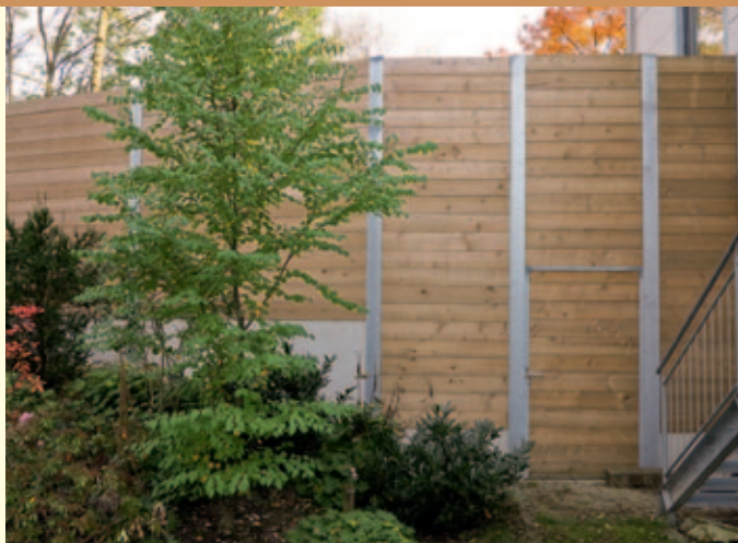
Lärmschutzwand Nr. 58.5, ca. 4 m hoch mit Bohlen 77 x 160 mm und Betonteil. Wandanschluss mit U-Träger und Lärmschutztüre auf Stahlrahmen
