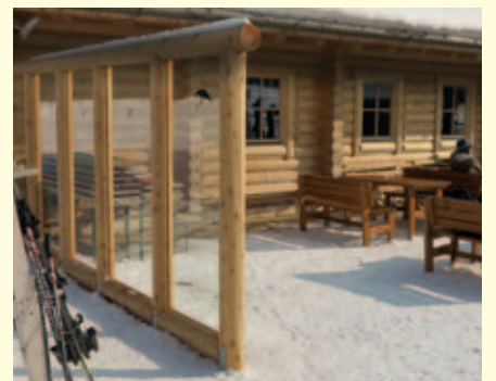
Stabile Windschutzglaswand in 16 cm starke Lärchenrundhölzer eingebaut.
