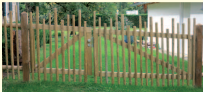
Tor aus dem Winkel mit Hanichlfüllung
