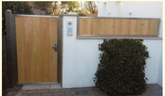
Sichtschutztor mit Wandelement in Edelstahlrahmen montiert.
