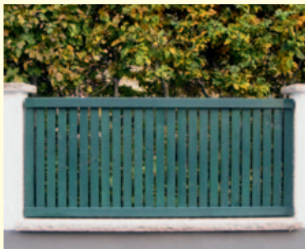
Speziell angefertigter Zaun Fichte kesseldruckimprägniert nachgetrocknet und 2x lasiert.
