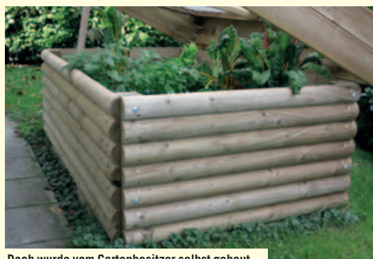
Dach wurde vom Gartenbesitzer selbst gebaut.
