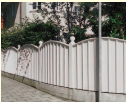
Villenzaun kesseldruckimprägniert, getrocknet, weiß grundiert und weiß lasiert. Auf alte Mauer montiert.
