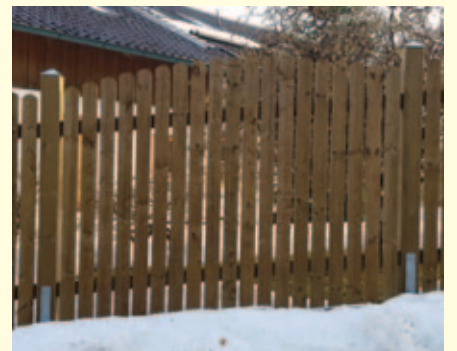
Hobellattenzaunfelder oben rund, dem schrägen Gelände angepasst.
