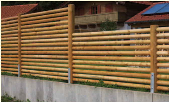
Sichtschutzwand aus Lärchenrundhölzern in ausgefräste Säulen montiert.
