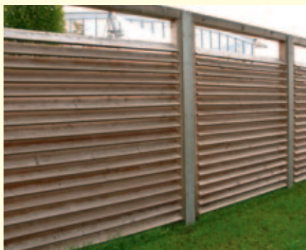
Sichtschutzwand aus Lärchenbohlen mit Aluwinkeln befestigt, für ein Schwimmbad.
