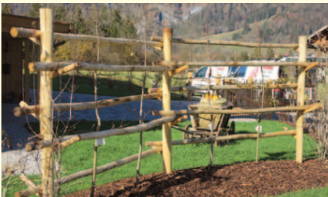
Spalier aus ungleich geschälten Kastanienrundhölzern.
