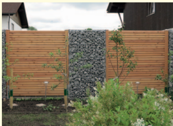
Zaungabionen mit Lärchen-Rhombuslattenzaun kombiniert. Auf Maß gefertigt.
