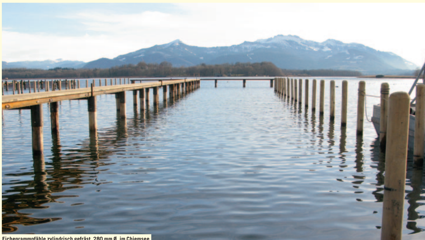
Eichenrammpfähle zylindrisch gefräst, 280 mm Ø, im Chiemsee
