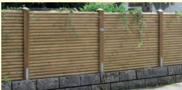
Sichtschutzzaun auf alte Mauer befestigt. An der Innenseite Wand mit 1 m tief einbetonierten HEA-Trägern stabilisiert.
