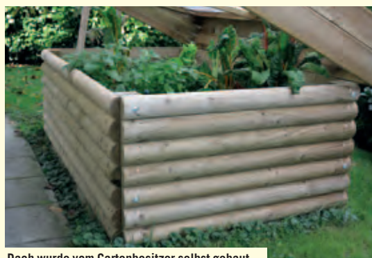
Dach wurde vom Gartenbesitzer selbst gebaut.
