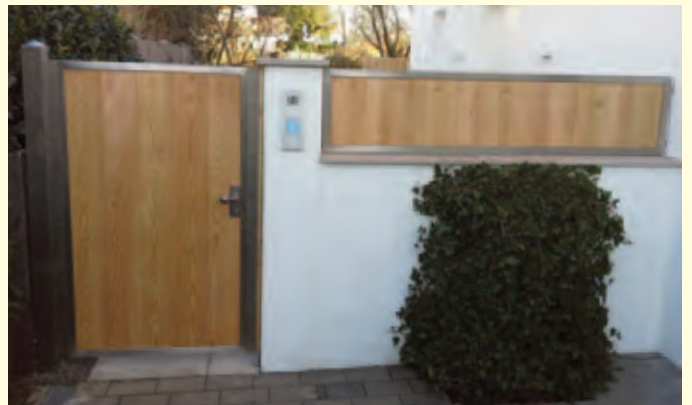
Sichtschutztor mit Wandelement in Edelstahlrahmen montiert.
