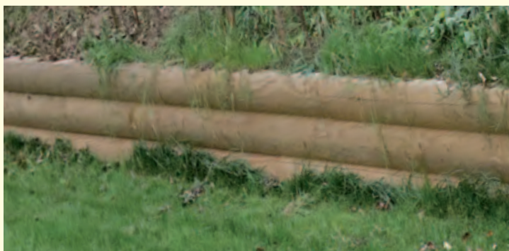
Böschungabsicherung mit profilierten Fichtenrundhölzern Ø 16 cm, Fichte grün kesseldruckimprägniert.
