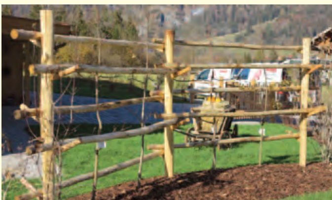
Spalier aus ungleich geschälten Kastanienrundhölzern.
