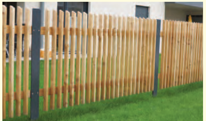
Hobellattenzaun zwischen beschichtete T-Profile montiert.
