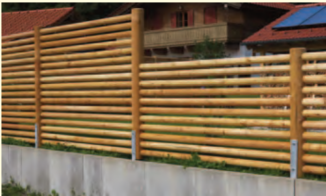
Sichtschutzwand aus Lärchenrundhölzern in ausgefräste Säulen montiert.
