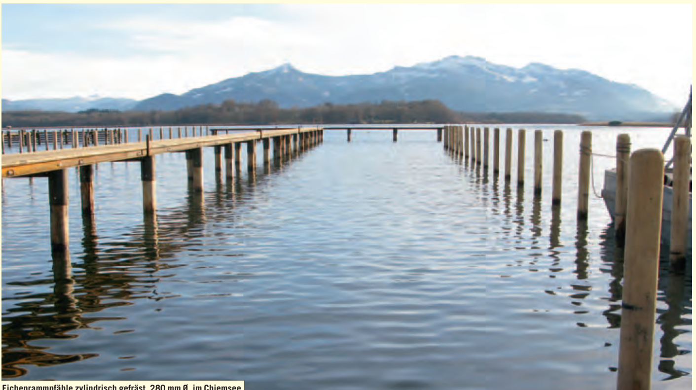
Eichenrammpfähle zylindrisch gefräst, 280 mm Ø, im Chiemsee
