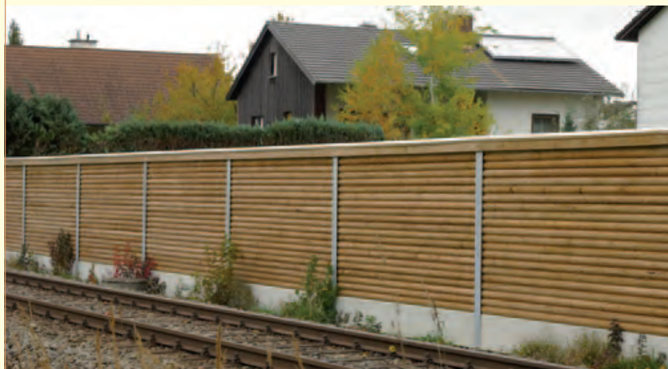
Reflektierende Rundholz-Lärmschutzwand Nr. 58.1 mit Abdeckdachl und Betonteil
