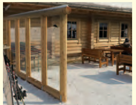
Stabile Windschutzglaswand in 16 cm starke Lärchenrundhölzer eingebaut.
