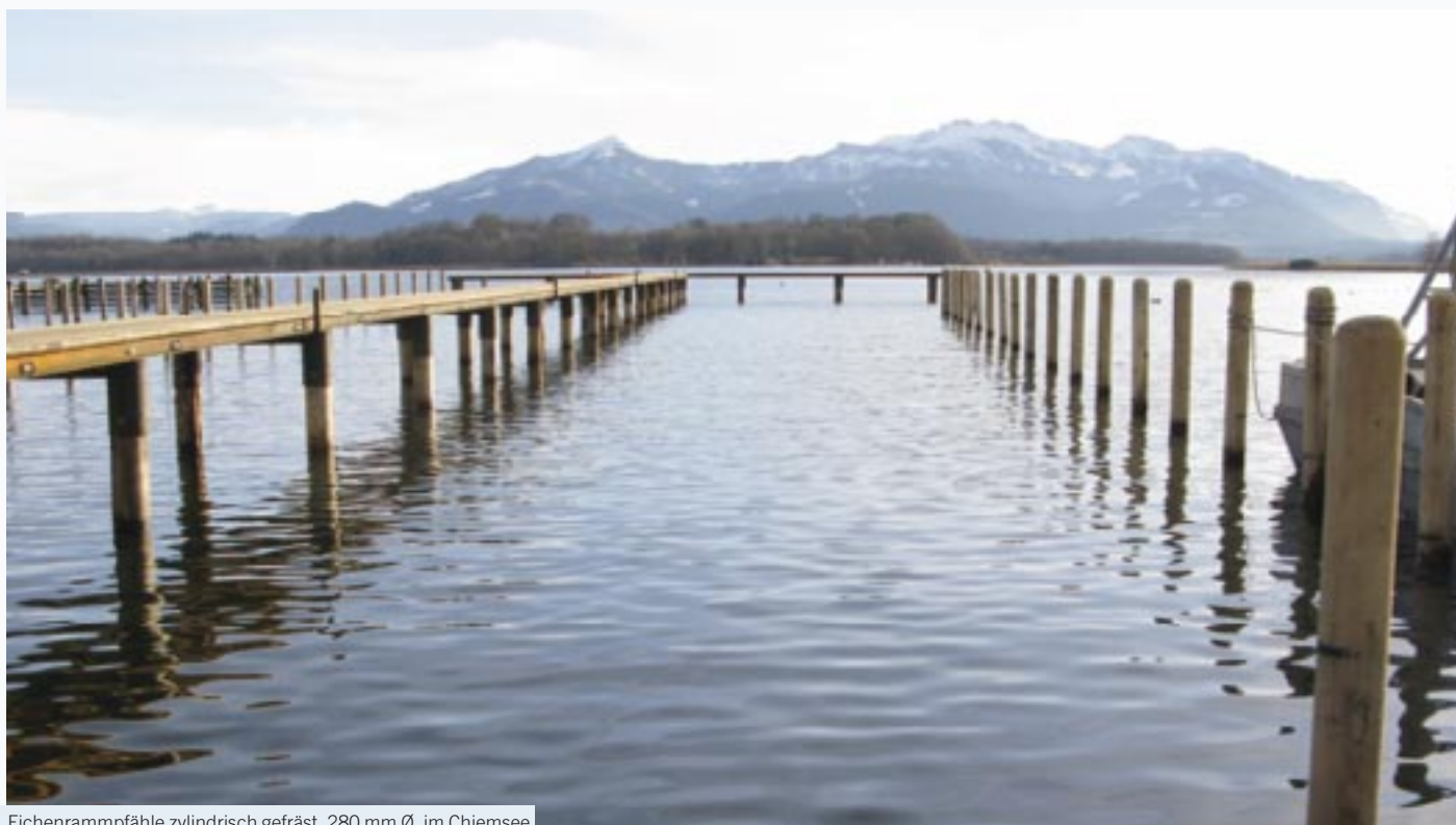
Eichenrammpfähle zylindrisch gefräst, 280 mm Ø, im Chiemsee
