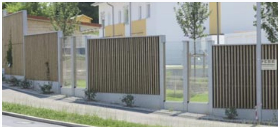
Hochabsorbierende Lärmschutzwand im Wechsel mit Glaselementen.
