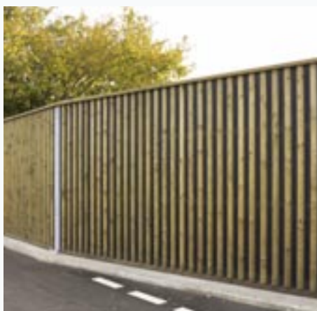
Abbildung rechts: Hochabsorbierende Lärmschutzwand auf Betonmauer mit schweren Spezialdübeln befestigt.
