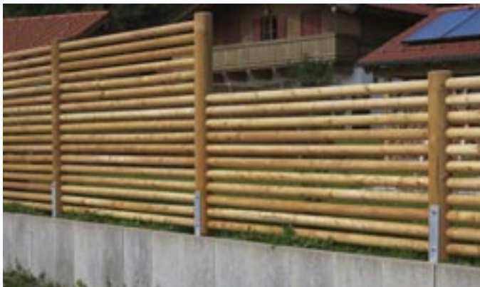
Sichtschutzwand aus Lärchenrundhölzern in ausgefräste Säulen montiert.
