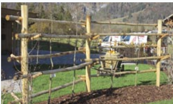
Spalier aus ungleich geschälten Kastanienrundhölzern.
