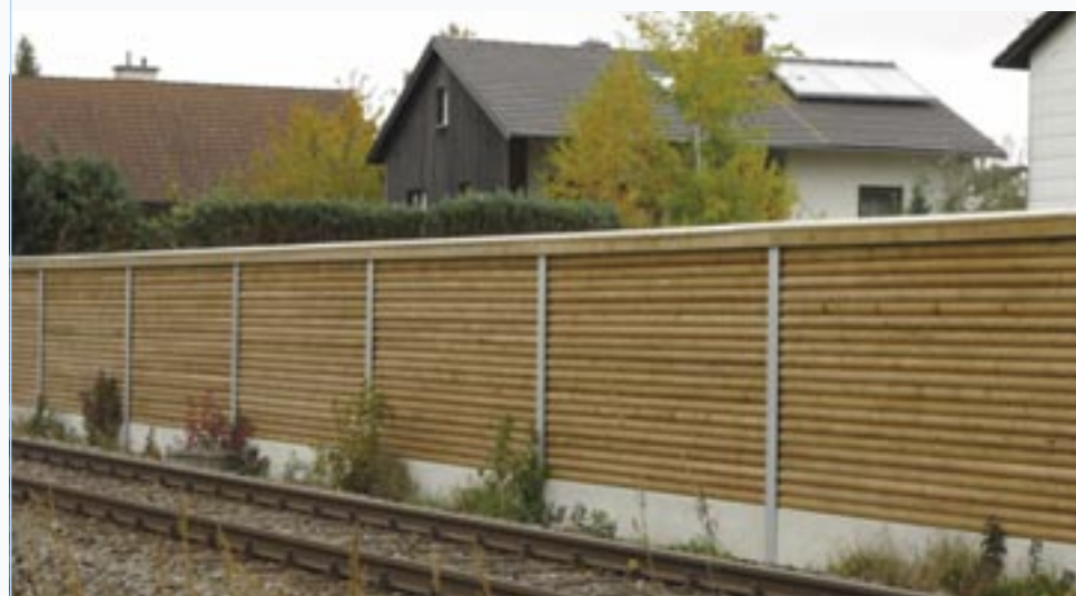
Reflektierende Rundholz-Lärmschutzwand Nr. 58.1 mit Abdeckdachl und Betonteil
