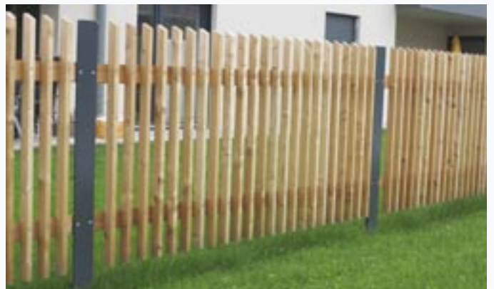
Hobellattenzaun zwischen beschichtete T-Profile montiert.
