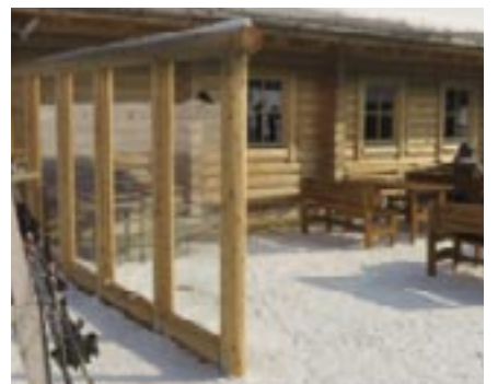
Stabile Windschutzglaswand in 16 cm starke Lärchenrundhölzer eingebaut.
