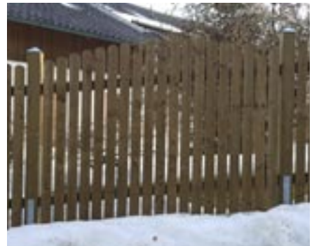
Hobellattenzaunfelder oben rund, dem schrägen Gelände angepasst.
