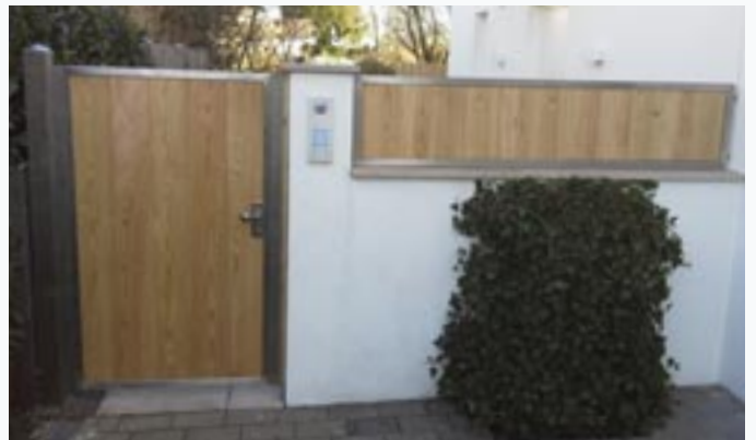
Sichtschutztür mit Wandelement in Edelstahlrahmen montiert.
