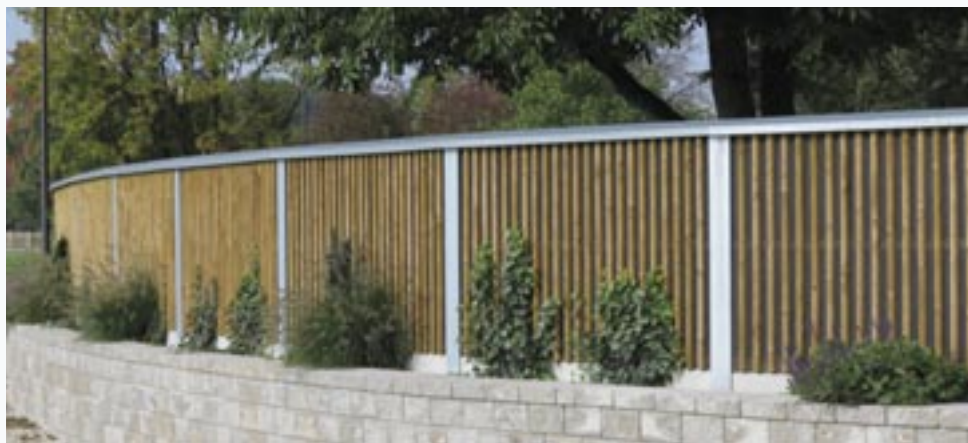
Hochabsorbierende Lärmschutzwand hinter bauseitige Steinmauer gebaut.
